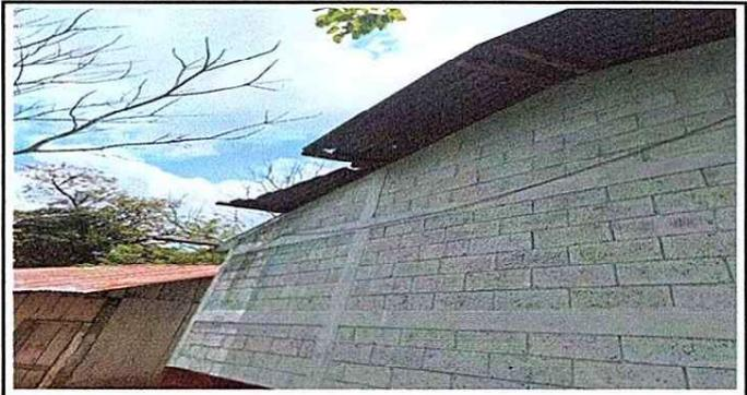
Foto 2: Se observa deterioro de láminas.
