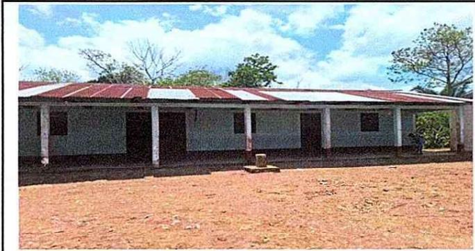
Foto 1: Deterioro de techo de todas las láminas.
