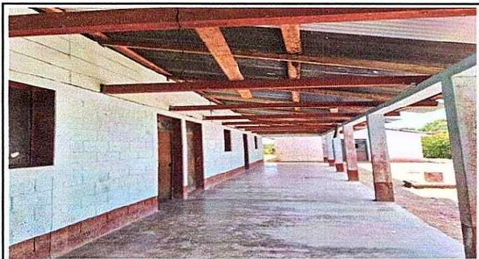
Foto 3: Se observa deterioro de costaneras, tijeras, vigas.
