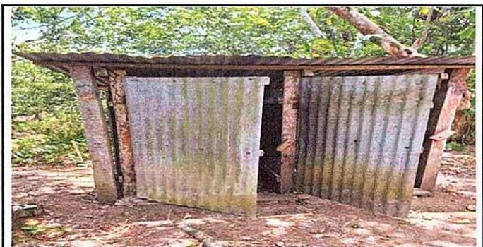
Foto 6: Se observa deterioro de las paredes y láminas del sanitario.
